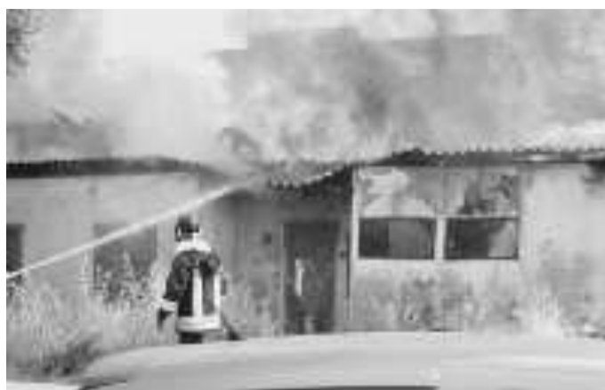
Il devastante incendio che aveva distrutto il tetto dell'ex scuola
